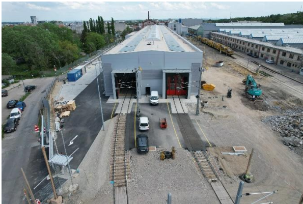
Die neue Servicehalle im Bau
